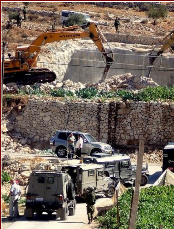
Demolizione di una cisterna sotterranea per l'acqua 03.09.2009
